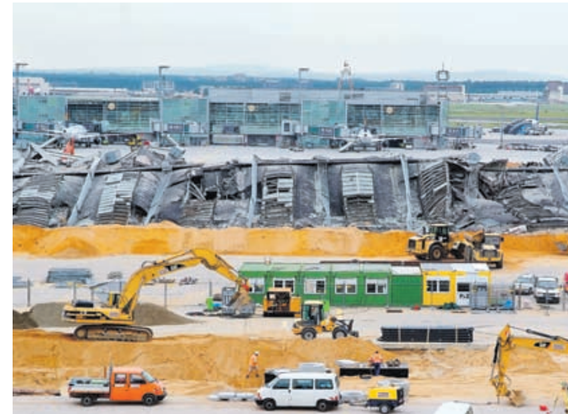
Ein Tag nach der Sprengung – 21.000 Tonnen Schutt müssen bis Ende dieses Jahres abgetragen werden.
