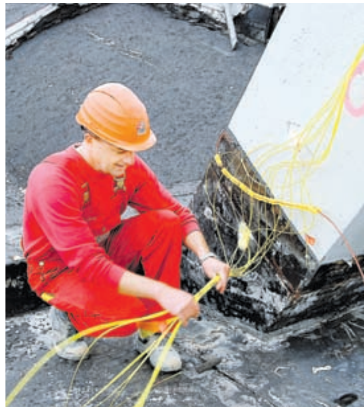
Ladearbeiten – Die Sprengsätze werden mit Kabeln verbunden.
